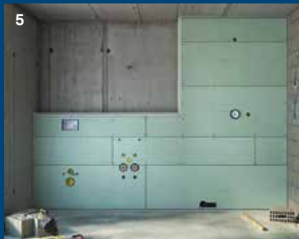
5 Poser le revêtement mural horizontal avec panneaux Duofix. La surface est désormais prête à être carrelée.
