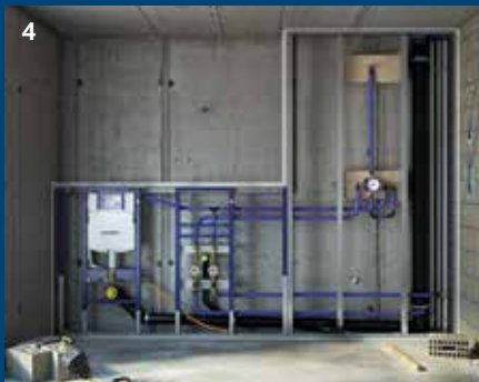
4 Installer le réseau d'alimentation d'eau potable avec Geberit Mepla, Volex ou PushFit pour les bâti-supports concernés.
