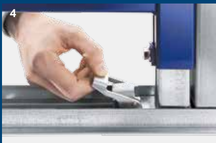
4 ... et ensuite au niveau des pieds bloquer le bâti-support à l'aide de clips.
