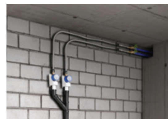
Canalisations de raccordement vers des parties inutilisées du bâtiment
