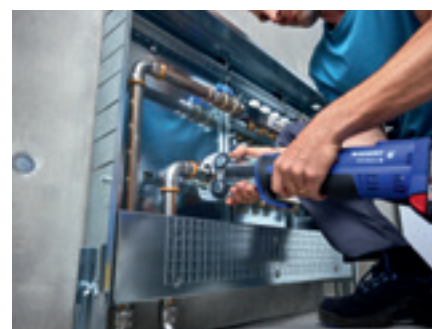
Éprouvé des milliards de fois : Geberit Mapress Therm fonctionne de la même manière que les autres systèmes Mapress, sans nécessiter de nouveaux outils.
