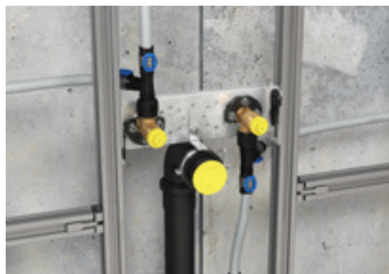
Raccord de transition Geberit avec MasterFix pour le contrôle clairement audible d'une bonne installation.
