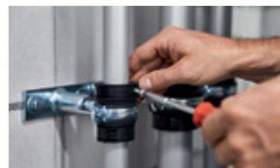
que soit la position des raccords. Si nécessaire, la position peut également être réglée ou corrigée ultérieurement une fois l'installation terminée.
